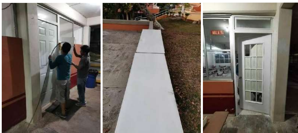
Ilustración 43. Mantenimiento de puertas.
