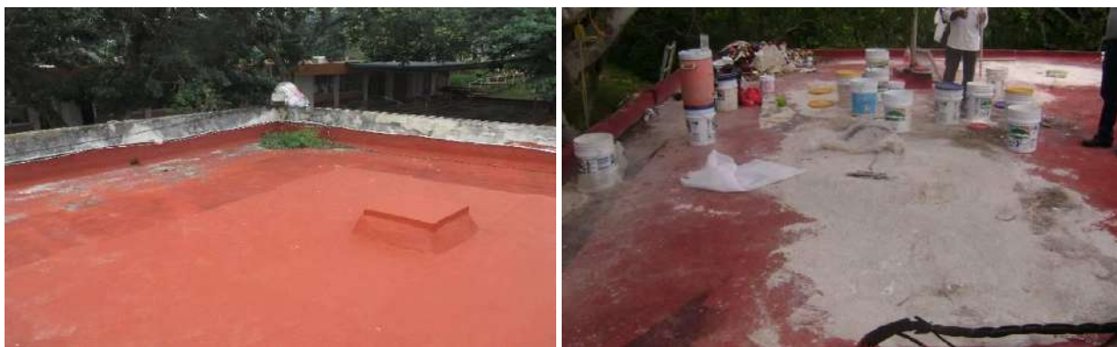
Ilustración 31. Mantenimiento de reparación de techos e impermeabilización.
