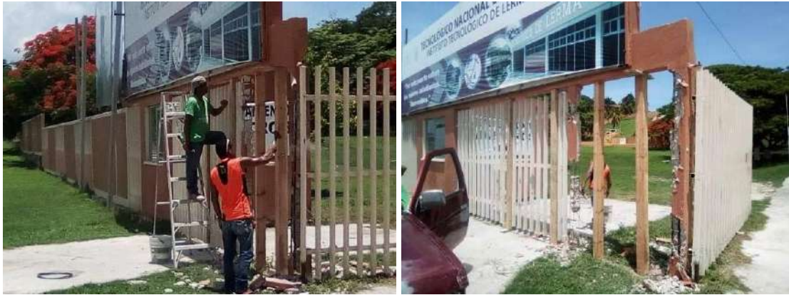
Ilustración 44. Mantenimiento de acceso principal.
