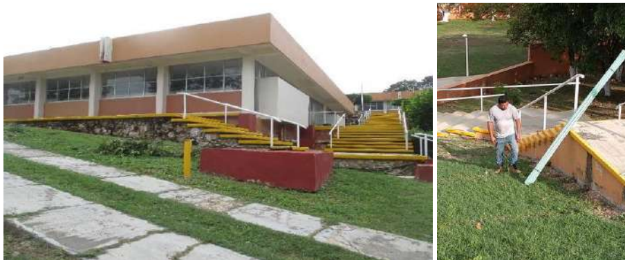
Ilustración 33. Mantenimiento en pintura a escaleras de acceso.
