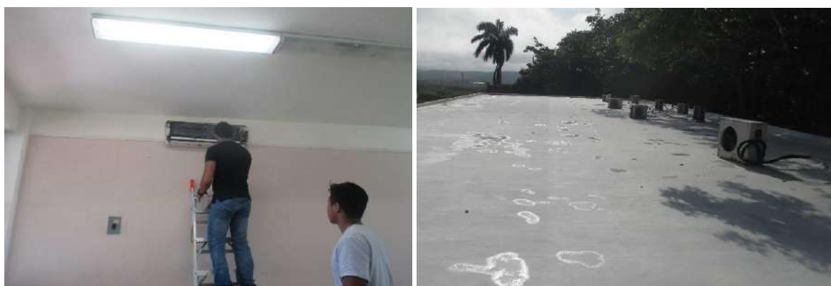
Ilustración 29. Mantenimiento en aires acondicionados.
