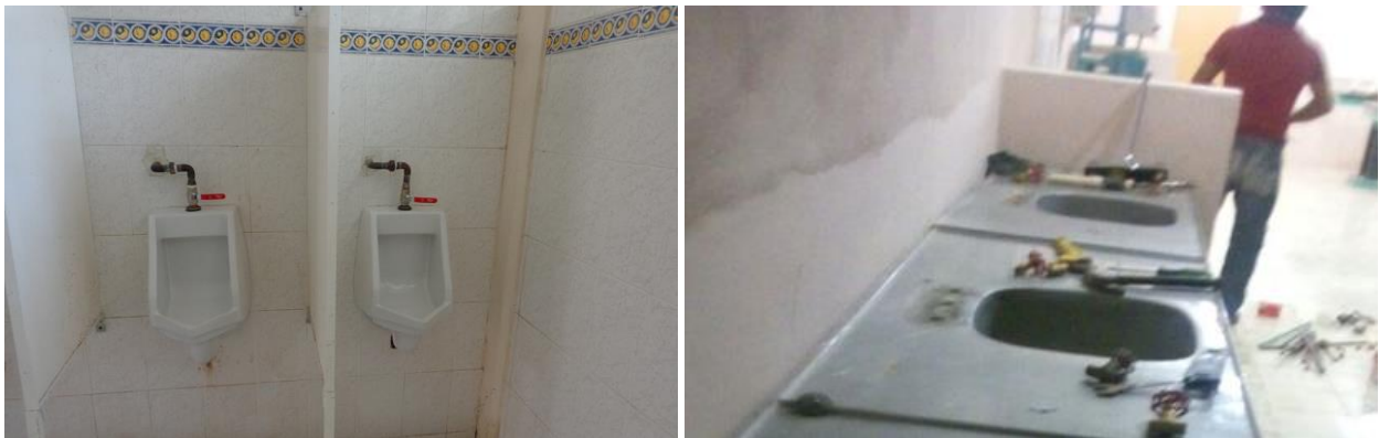
Ilustración 32. Mantenimiento a sanitarios en cambio de llaves de control y herrajes.
