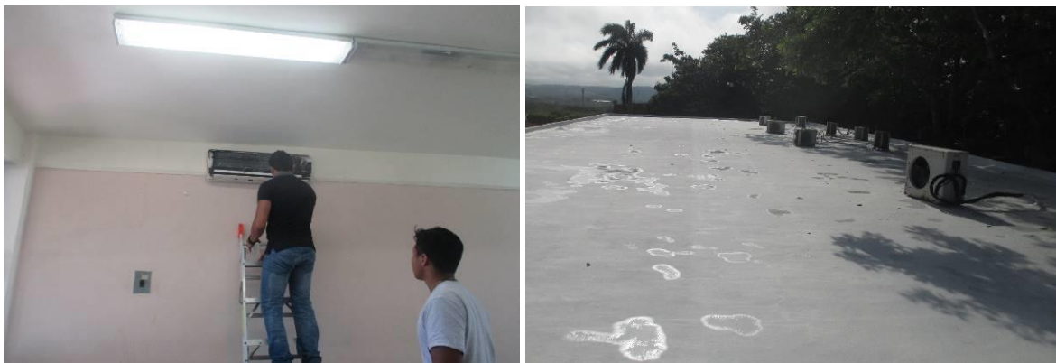
Ilustración 29. Mantenimiento en aires acondicionados.
