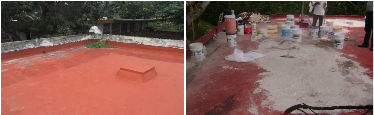
Ilustración 31. Mantenimiento de reparación de techos e impermeabilización.
