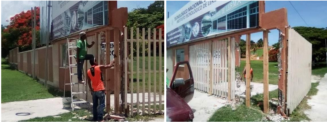
Ilustración 44. Mantenimiento de acceso principal.
