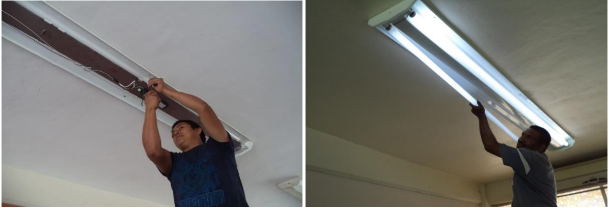
Ilustración 30. Cambio de lámparas internas y externas en aulas, talleres, oficinas, laboratorios y pasillos.
