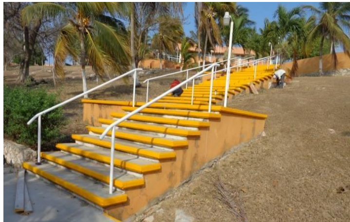
Ilustración 35. Escaleras de acceso al plantel.
