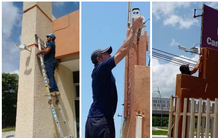
Ilustración 45. Colocación de cámaras de seguridad para un buen servicio educativo.
