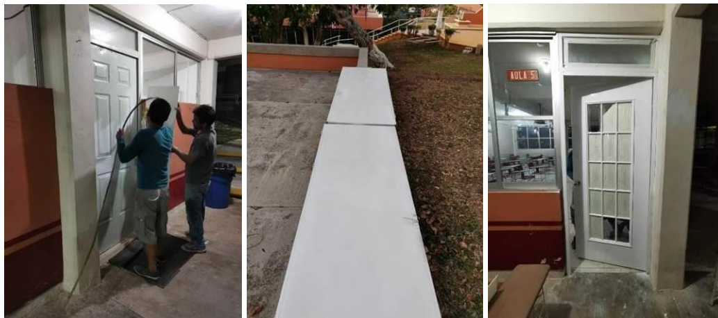
Ilustración 43. Mantenimiento de puertas.
