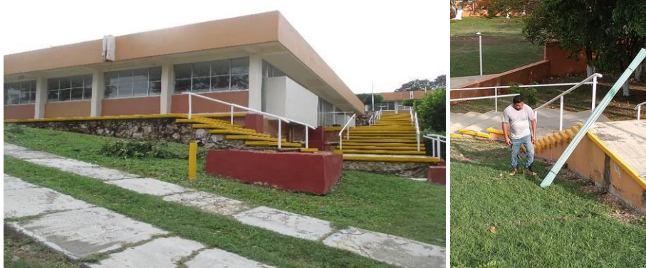
Ilustración 33. Mantenimiento en pintura a escaleras de acceso.
